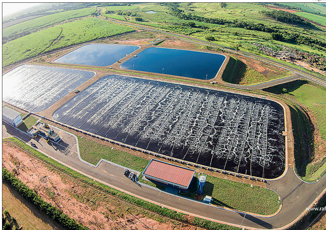
Estação integra um complexo centralizado que entrou em funcionamento em 2015, em Catanduva
